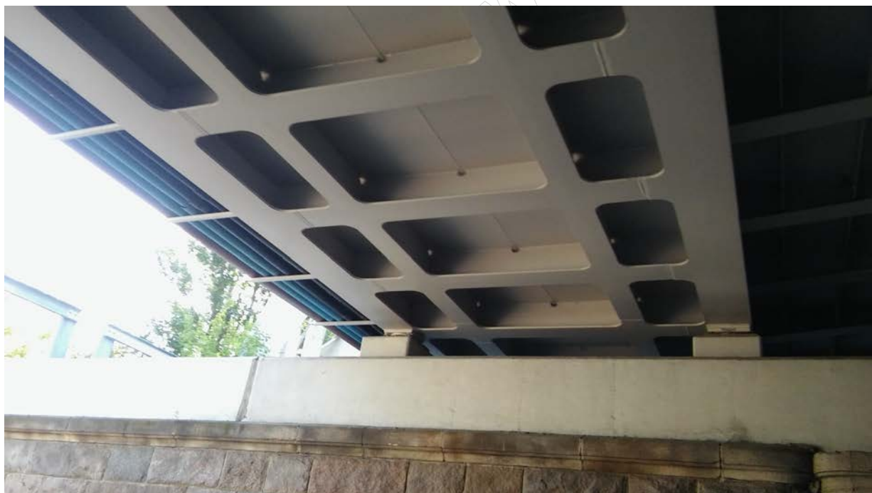
Rysunek 2. Widok konstrukcji od spodu
