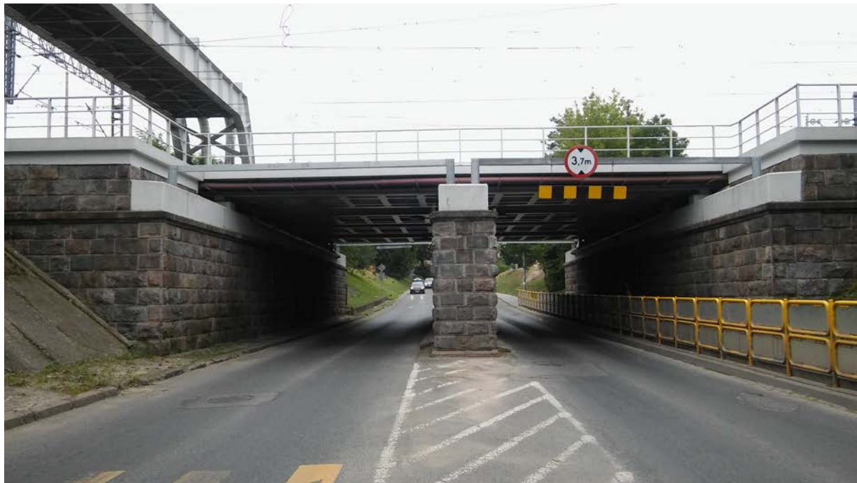
Rysunek 1. Widok wiaduktu kolejowego
