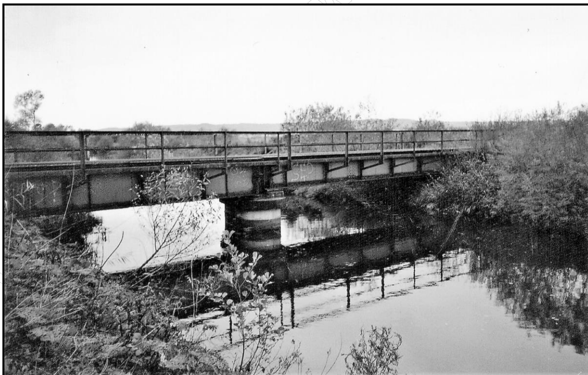
Rysunek 1. Widok mostu kolejowego
