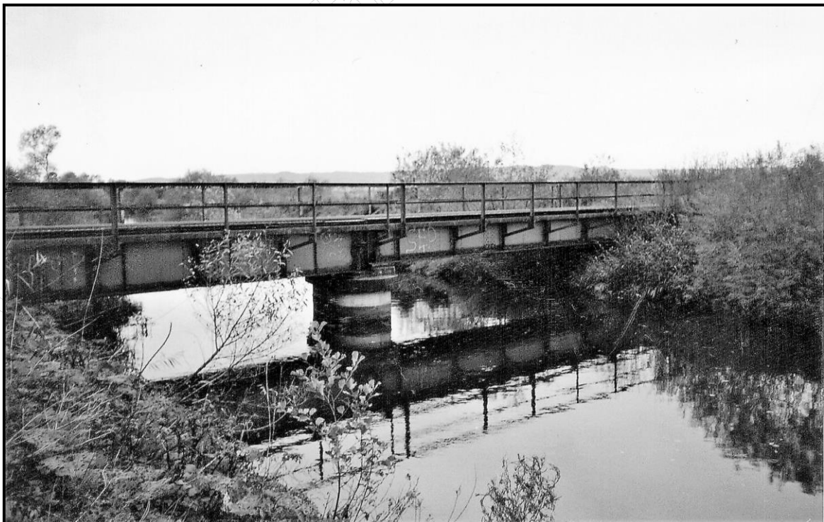
Rysunek 1. Widok mostu kolejowego
