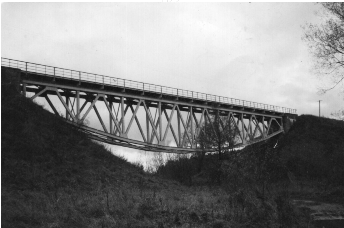
Rysunek 1. Widok mostu kolejowego
