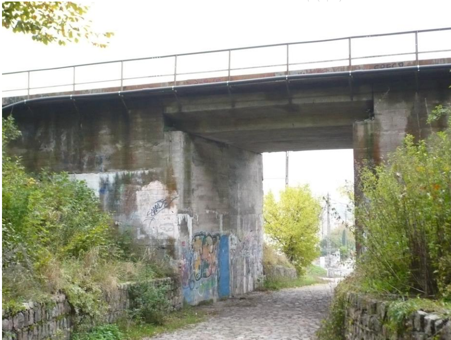
Kolejowy obiekt inżynierski
